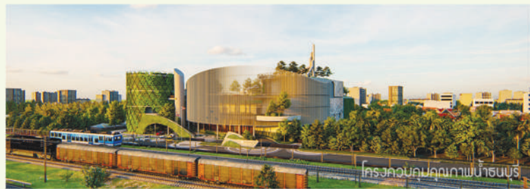
โครงการก่อสร้างระบบรวบรวมน้ำเสีย และระบบบำบัดน้ำเสียธนบุรี
