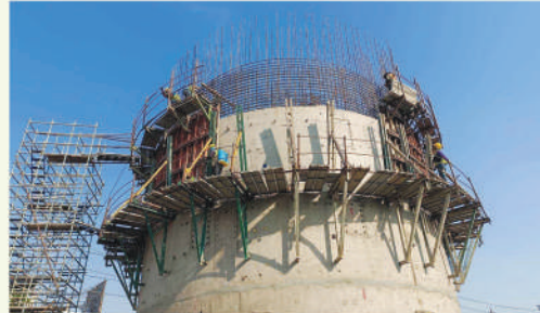
โครงการก่อสร้างอุโมงค์ระบายน้ำคลองทวีวัฒนาบริเวณคอขวด
