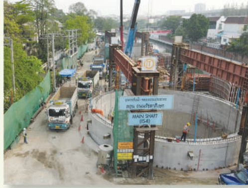
โครงการก่อสร้างอุโมงค์ระบายน้ำคลองเปรมประชากรจากคลองบางบัวลงสู่แม่น้ำเจ้าพระยา
