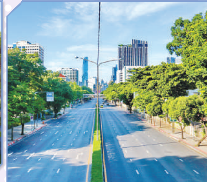
โครงการนำสายไฟฟ้าลงใต้ดิน กทม.
