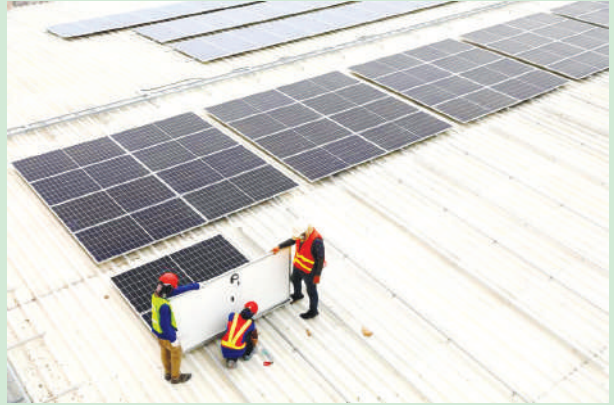
การติดตั้งโซลาร์ฟลอปบนหลังคาโรงงาน
