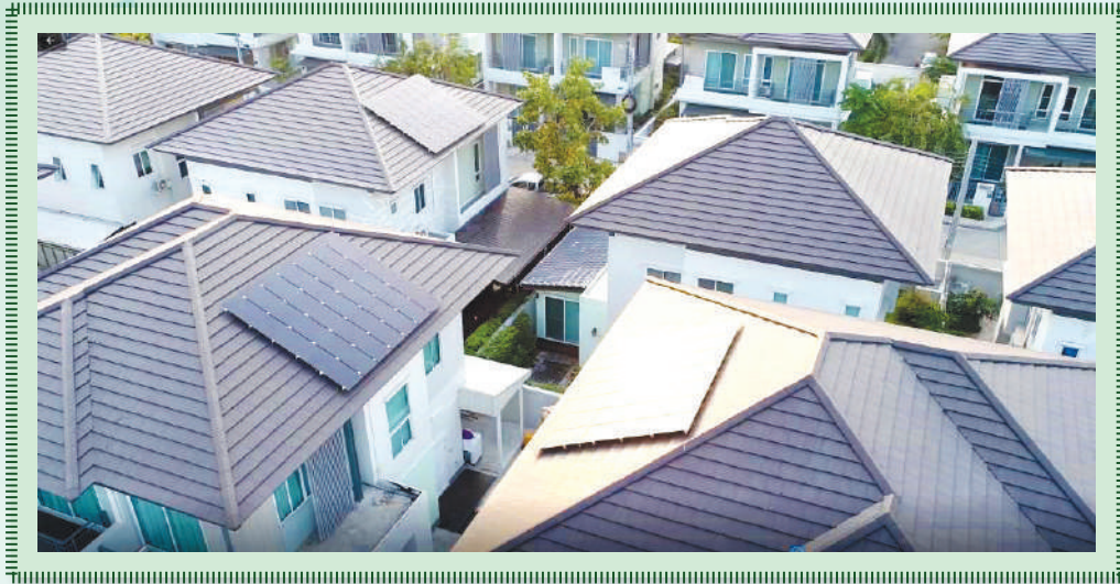
โครงการหมู่บ้านจัดสรรที่ติดตั้งโซลาร์รูฟท็อปขายพร้อมบ้าน
