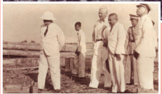
พันเอกพระยาพลพลพยุหเสนา ตรวจเยี่ยมความคืบหน้าในการก่อสร้างเขื่อนตะวันตก ท่าเรือกรุงเทพ นายโรเบิร์ต ชาวเทก วิศวกร ผู้ควบคุมการก่อสร้าง และศาสตราจารย์ เอ. อากัดซ์ผู้ออกแบบและที่ปรึกษาการก่อสร้าง นำชมการก่อสร้าง พ.ศ. 2475
